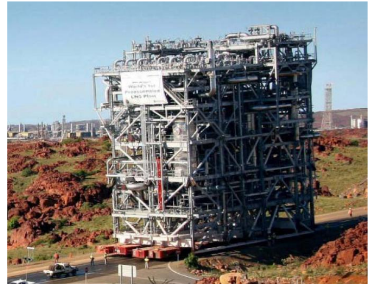
One of the 261 modules for the 4.3 mtpa Pluto LNG plant
